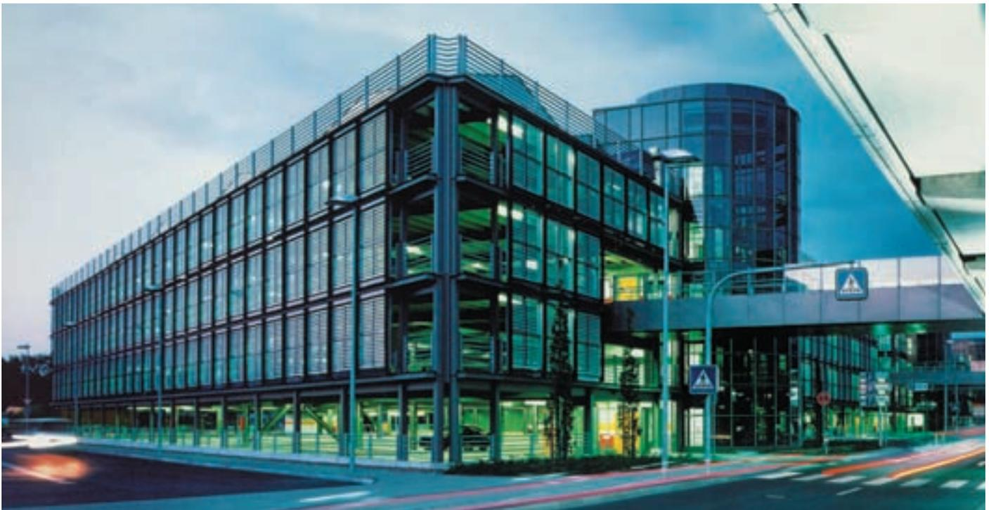
In einer Arbeitsgemeinschaft mit der Strabag entstand das Parkhaus 3 mit 2.405 PKW-Einstellplätzen auf 5 Ebenen. Der vierschiffige Stahlverbundbau misst ca. 250 x 65 m, ist teilverglast und mit Aufzügen ausgestattet. Neben den Brücken lässt sich das Gebäude auch über eine gegenläufige Spindelrampe befahren.
