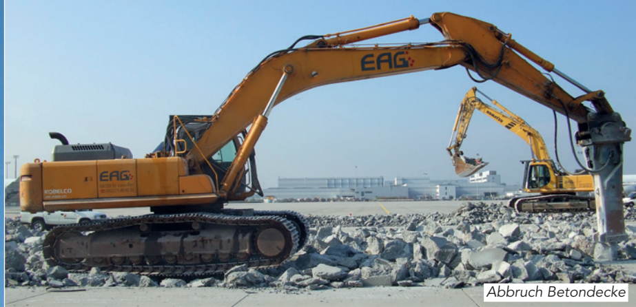
Gebäudeabbruch mit Longfront
