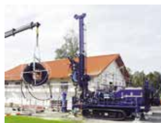
Erdsondenbohrung für eine Sole/Wasser-Wärmepumpe
