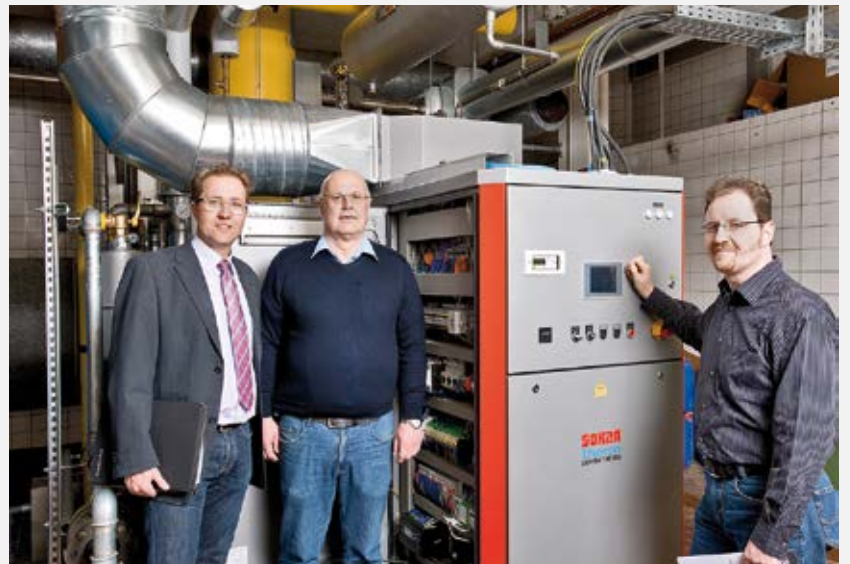
Daniel Rohring brachte das BHKW mit Bernhard Wending und Martin Deelmann vom St. Marien-Hospital Borken auf den Weg (v. l.).
