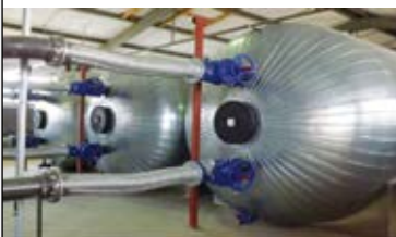
Speicherbatterie – 3x 100.000 Liter
