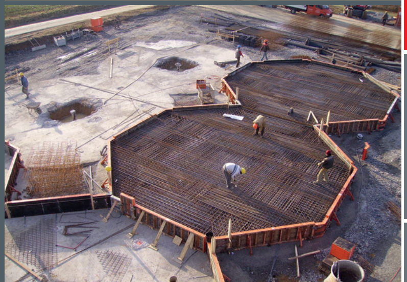
Fundamentierung für Getreidesiloanlage
