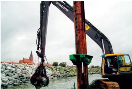
Die neue Mole hat eine Ausbauhöhe von ca. 2,80 m über dem Mittelwasser des Boddens. Sie kann selbst bei extremen Sturmflutereignissen die verbleibende Wellenhöhe auf 21cm reduzieren und schützt somit die Kaianlagen, die touristische Infrastruktur, Werft- und Fischereianlagen sicher vor Hochwasser und starken Seegang. Durch die nach Norden verschobene Trasse wurde zudem die Hafensfläche auf etwa das Doppelte vergrößert.
