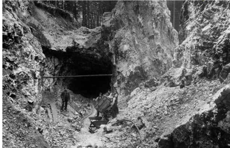
Der Schwerspatgang erreichte im Bereich der Grube Johanne eine Mächtigkeit von bis zu 30 Metern. Um das Jahr 1910 wurden diese Gangpartien noch im Tagebau durch die Bergleute abgebaut. Mit dem Pachtvertrag zu dieser Grube verpflichtete sich Dr. Alberti gegenüber der Forstverwaltung zum Bau einer Kleinbahn von den Gruben bis zum Werk in Lauterberg.
