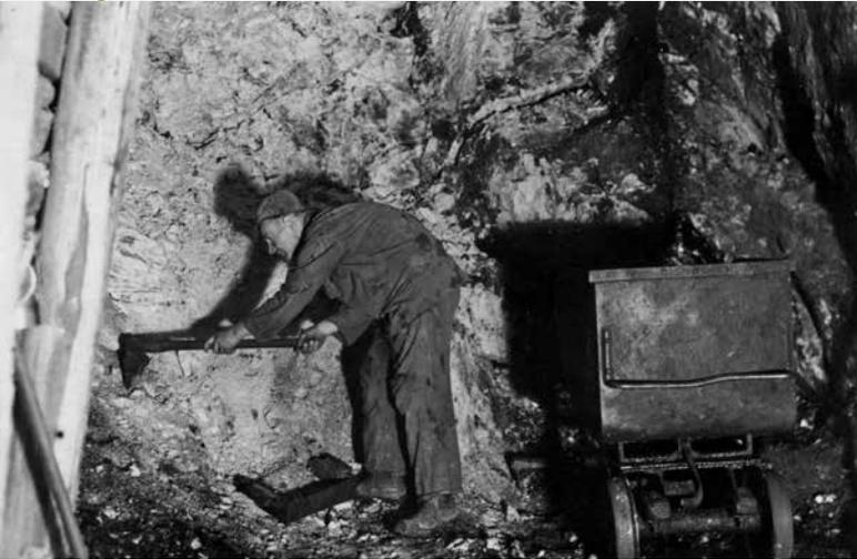
Mit der Kratze schiebt der Bergmann das Haufwerk auf den Trog, der anschließend in den Förderwagen entleert wird. Bis Ende der 1960er Jahre war dies in den hiesigen Gruben eine übliche Arbeitsmethode vor Ort.
