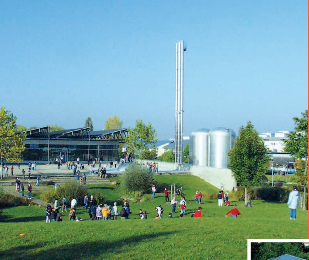
Zentrale der Nahwärmeversorgung Grenchenstraße in Amorbach
