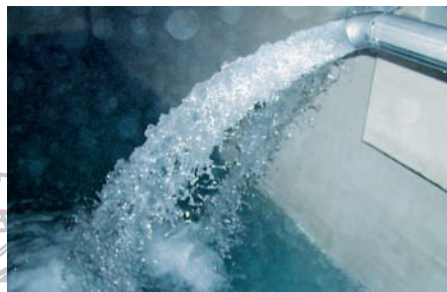
Wir sorgen für ausreichend Nachschub (Einspeisung von Brunnenwasser in den Hochbehälter)
