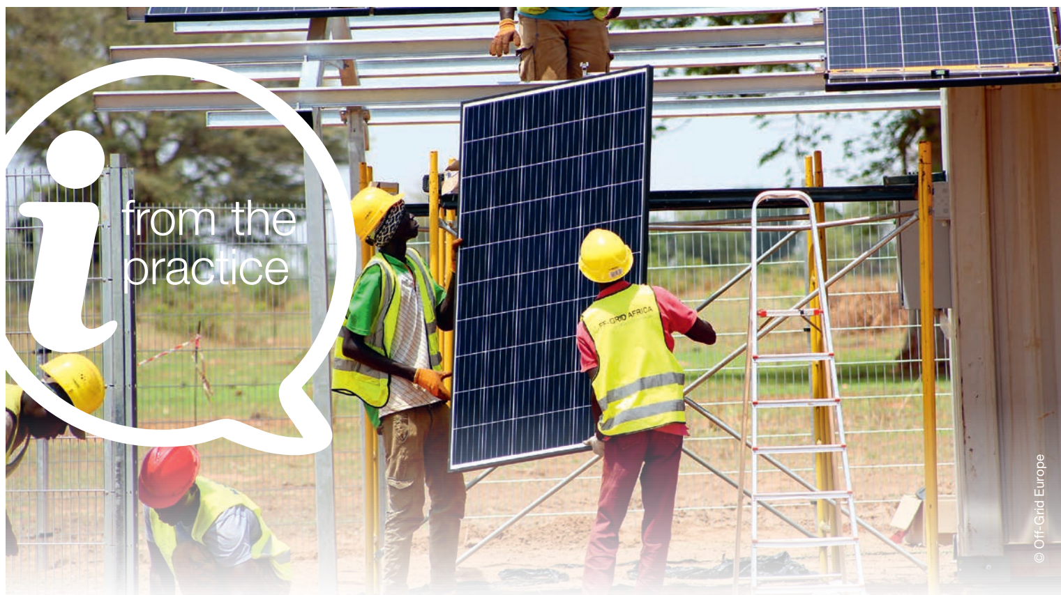
Mitarbeiter von Off-Grid Africa bei der Installation eines Mini-Netzes Off-Grid Africa staff installing a mini-grid
