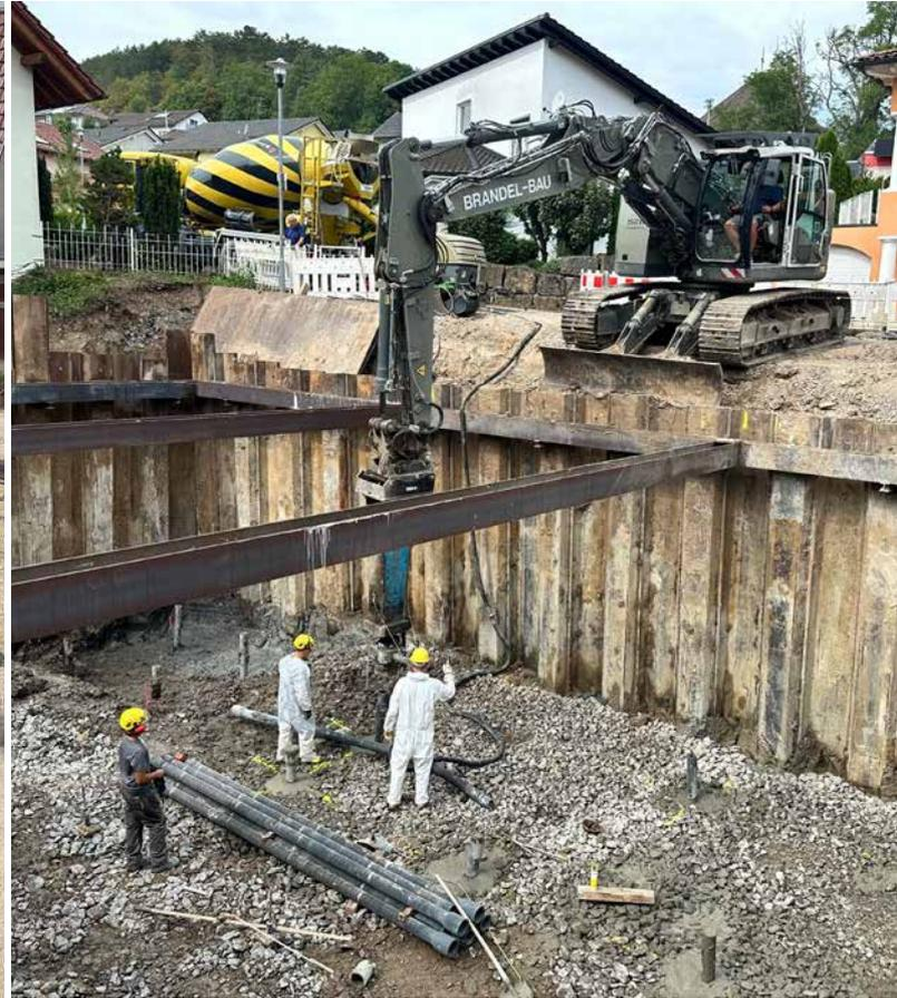
Bei nicht tragfähigem Baugrund setzen wir auf duktile Gusspfahlgründungen – ein flexibles, modulares System zur Absicherung von Bauwerkslasten.
