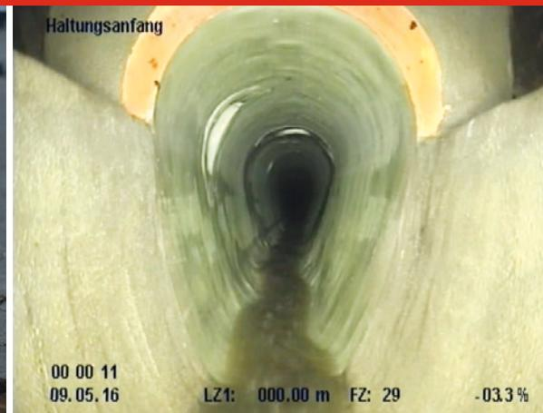
GFK-SCHLAUCHLINER MIT UV-HÄRTUNG
