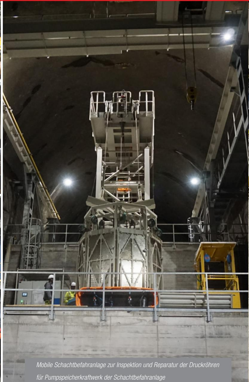
Mobile Schachtbefahranlage zur Inspektion und Reparatur der Druckröhren für Pumpspeicherkraftwerk der Schachtbefahranlage
