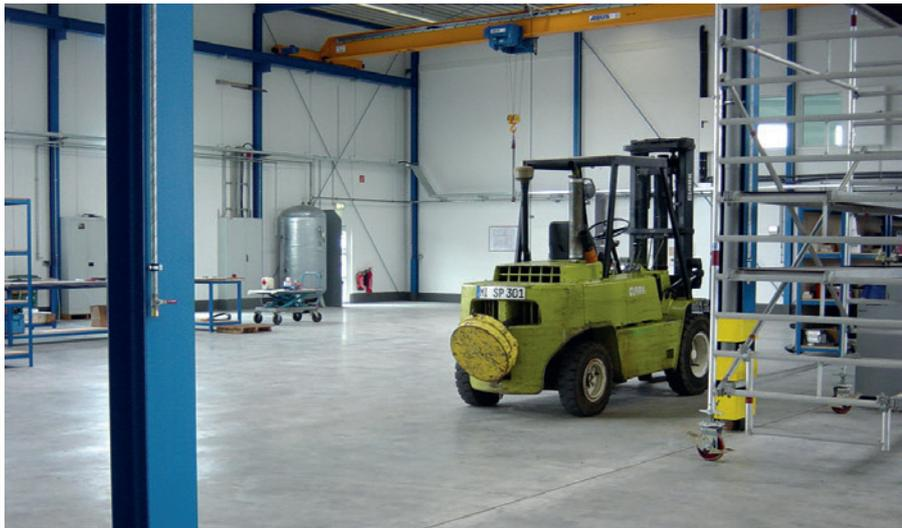
Bei den Klassikern von Condulith® handelt es sich um Stahlbetonbodenplatten mit Scheinfugen aus Spezialbeton, die für Sonderlösungen des Industriebodenbaus bei anspruchsvollen Einsätzen geeignet sind.
