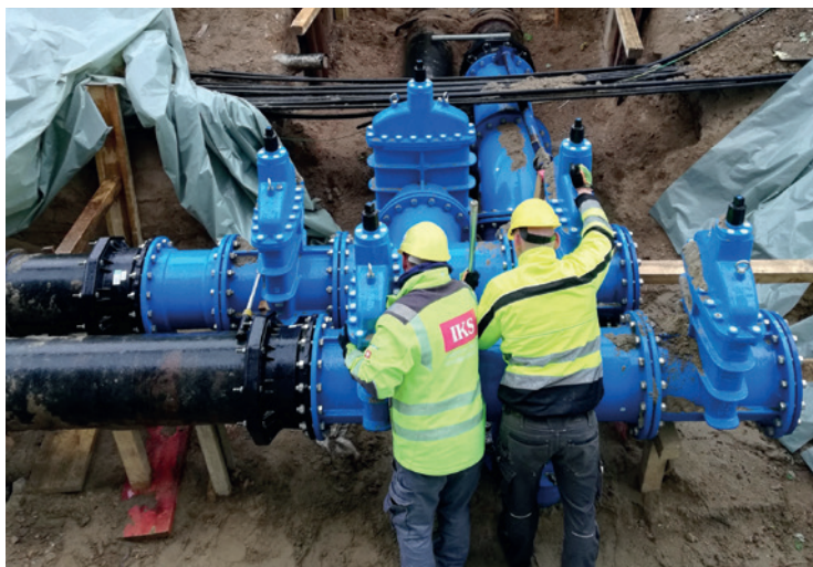
PE-Rohrleitungsbau mit Gusschiebern
