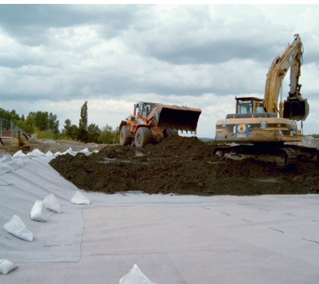
Einbau von Reststoffen
