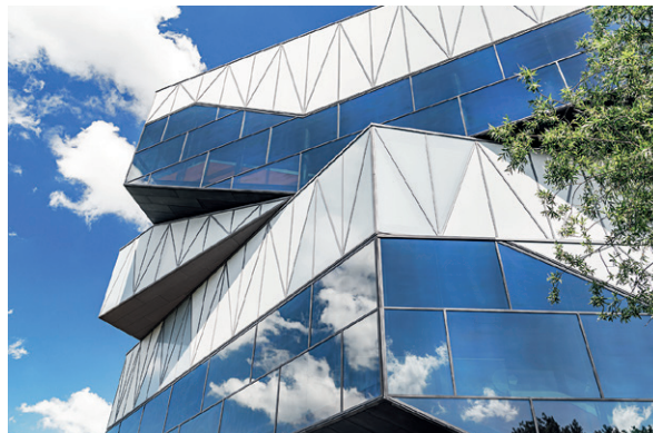
◀ Stahl-PR-Fassade und Dach Experimenta, Heilbronn
