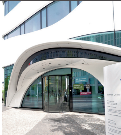
◀ Windfanganlage + Alu-Glattblech-Fassade Otto-Bock-Stiftung, Berlin
