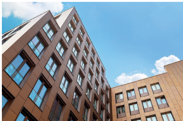
► Blechfassade Junghof Plaza, Frankfurt
