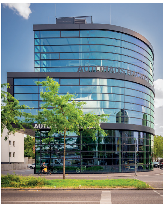
▼ Alu-Blechfassade (teilweise gebogen) Autohaus Hackert, Heilbronn
