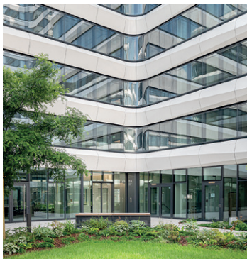
▲ Alu-PR-Fassade + Alu-Fensterbänder Gateway-Gardens, Flughafen Frankfurt
