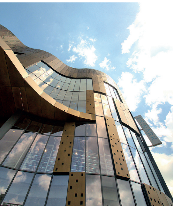
▼ VH Kupferfassade Kubus, Wuppertal
