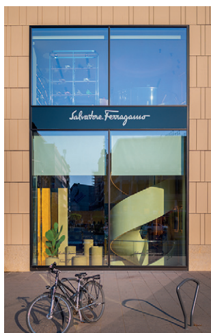
▲ Alu-PR-Fassade + Keramikverkleidung Goethestraße 2, Frankfurt
