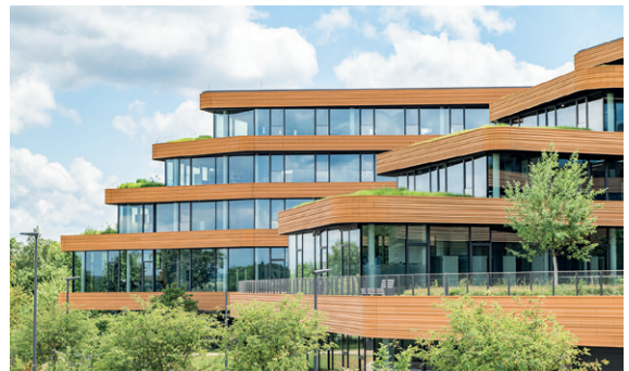
▲ Aluminium-PR Fassade mit Keramik Vorhang Lidl Hauptverwaltung, Bad Wimpfen
