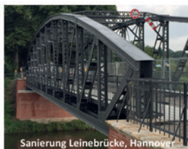
Sanierung Leinebrücke, Hannover
