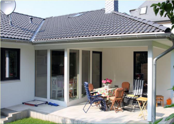
Ökologischer Holzbau in verputzter Fassade, inkl. massiver Lehminnenschale und Holzbalkendecke Standard; modernes Fachwerkelement verglast mit Winkelanbau als Terrassenüberdachung
