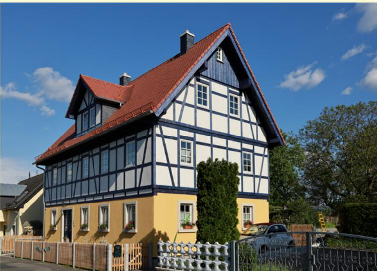
Ersatzneubau nach Totalabriss: Wohnhaus in Chemnitz-Rabenstein; Bau in Anlehnung der Oberrabensteiner Fachwerkhäuser; EG KEIN Massivbau, sondern ökologischer Holzbau vollflächig verputzt Special: echte Sandsteingewände; 48° DN mit Satteldachgaube straßenseitig und Trapezgaube gartenseitig; 4 Ebenen EG, 1. OG, DG und Abstell im Spitzboden
