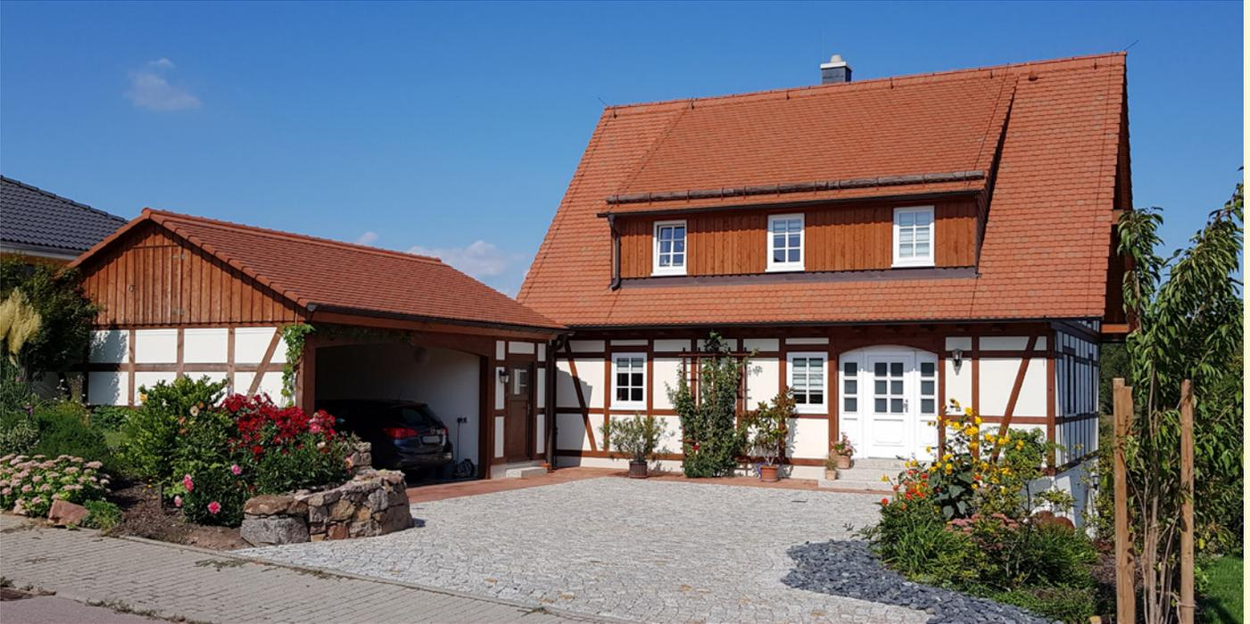
Aufwendige Details für gelungenes Design – Dachneigung 50° mit Schleppgauben, Dacheindeckung in Biberschwanz bunt, Spitzbogen mit 25 m<sup>2</sup> Ausbaureserve, Haustür mit Seitenteilen hinter Rundbogen, passendes Nebengebäude mit Satteldach 25° DN als Carport mit Rundbogenöffnung und Abstellraum
