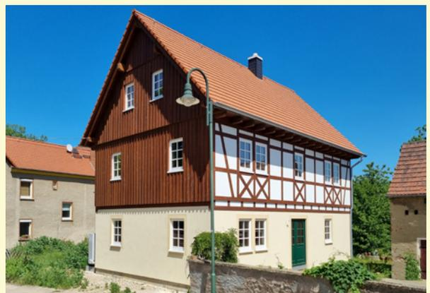
Ersatzneubau Wohnhaus in kleiner Hofanlage; EG KEIN Massivbau, sondern ökologischer Holzbau vollflächig verputzt, schlichter Baukörper mit straßenseitiger Holzverschalung; Dacheindeckung Biber wie Umgebungsbebauung des historischen Dorfangers; EG und 1. OG fertig, DG Kaldt Dach für späteren Ausbau
