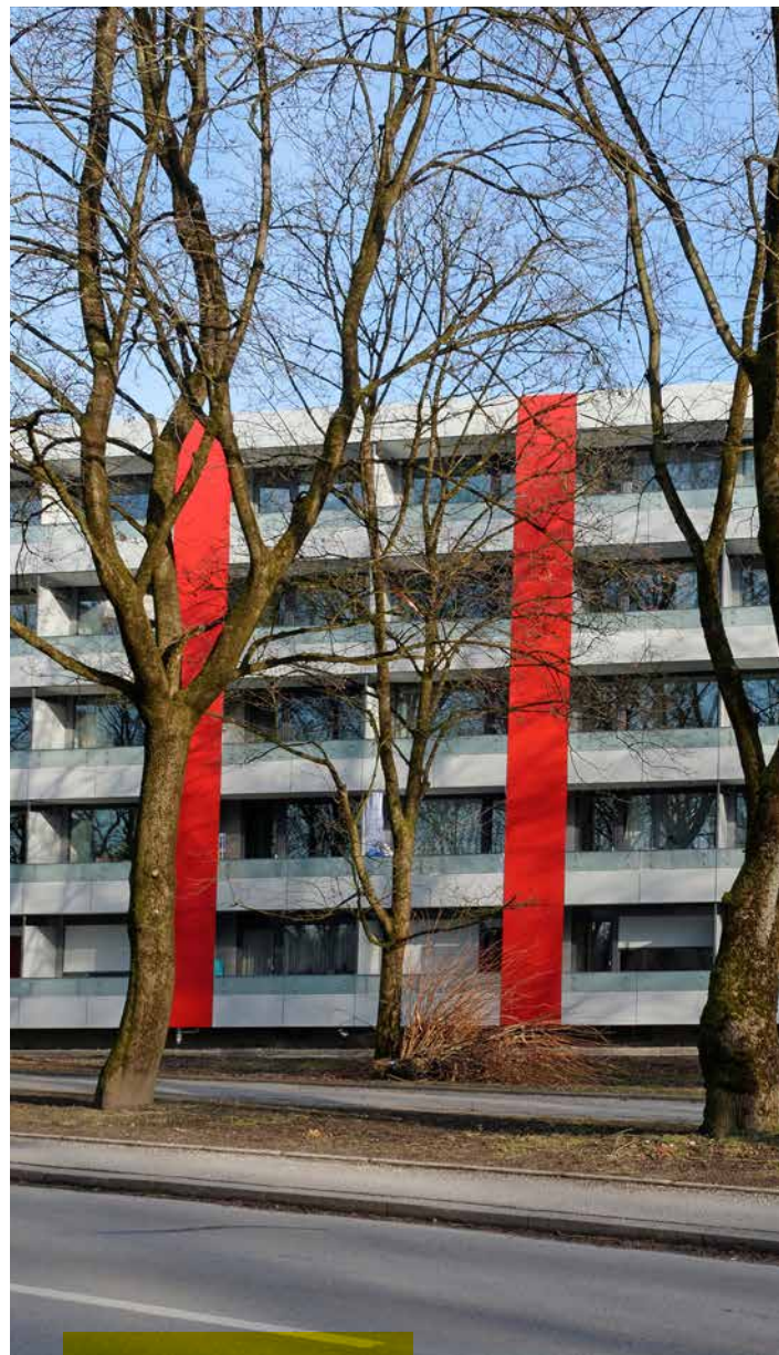
Fassade – nach der Sanierung
