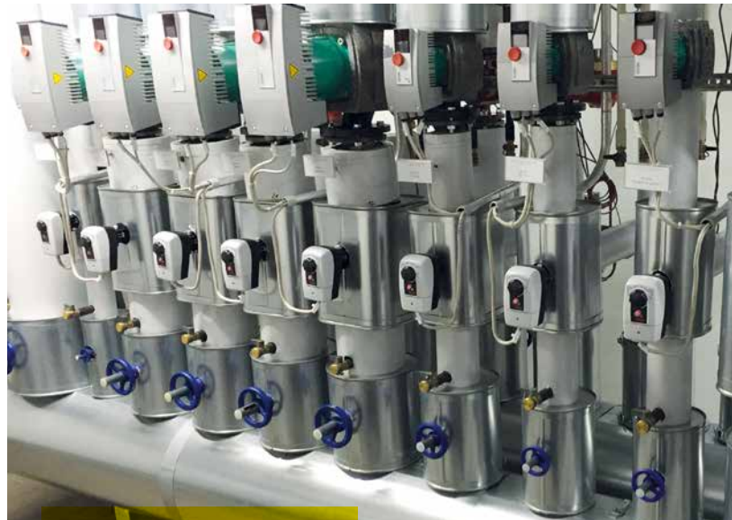
Haustechnik – nach der Sanierung
