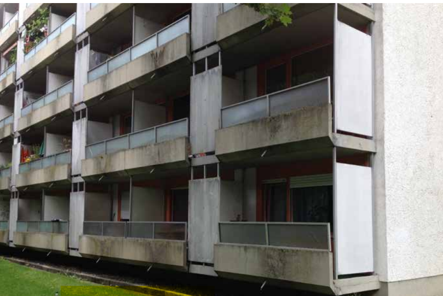
Fassade – vor der Sanierung
