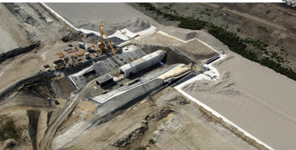
2007 Errichtung Tunnelbauwerk und Basisabdichtung
