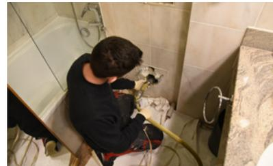
3. Aufbringen des 2-Komponenten-Reaktionsharzes mittels Sprüh- oder Bürstentechnik
