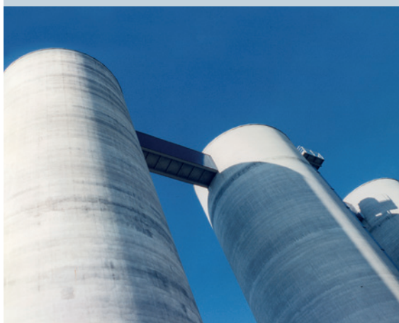
Zementsilos in Gleitschalungsbauweise
