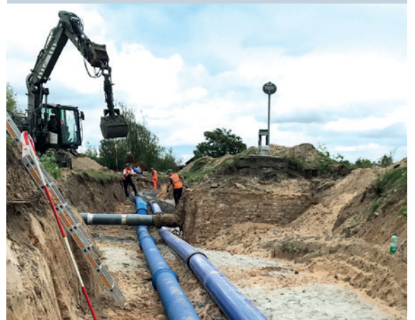
Druckrohrleitungsbau
