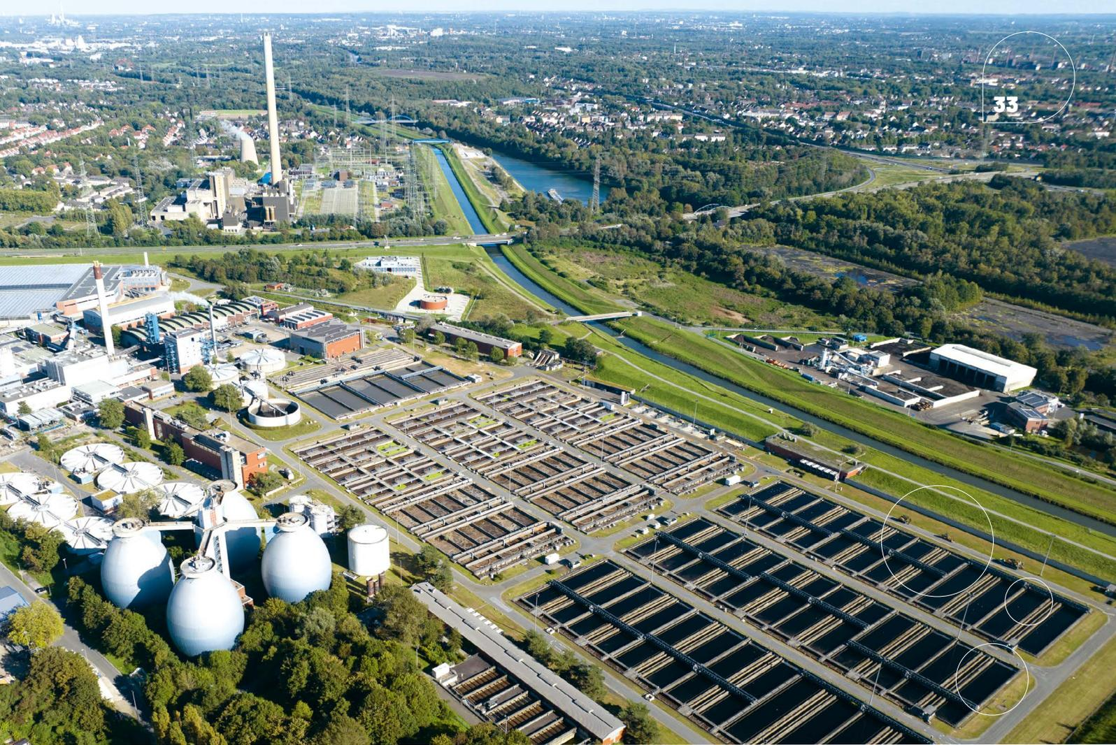
Basis des Projekts sind zwei Faktoren: Im Klärprozess fällt eine große Menge Kohlendioxid ( $\text{CO}_2$ ) an – und es gibt aus der Eigenenergieerzeugung der Kläranlage, die als einzige in Deutschland energieautark arbeitet, einen Überschuss an grünem Strom, der sich zu Wasserstoff umwandeln lässt. Ziel des Projekts ist, aus beiden Komponenten speicherfähiges Methanol herzustellen.
