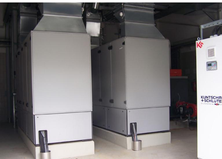
Blockheizkraftwerke (max. Leistung 360 kWh)
