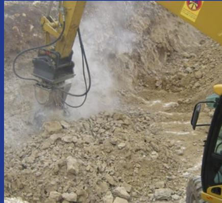
Baugrube mit Baggeranbaufräse
