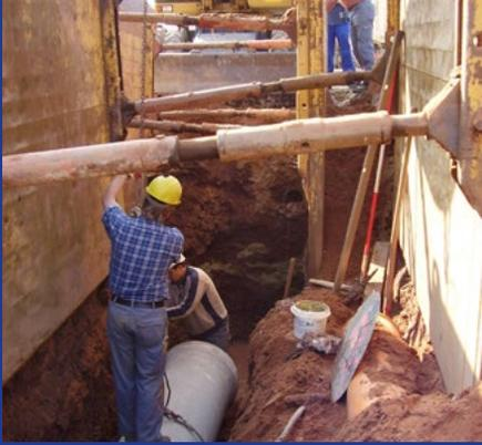
Kanalverlegung mit Verbau
