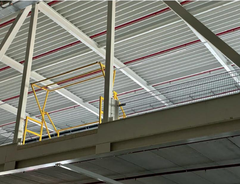
INTEGRA-pw 0.1 Brüstungssicherung, Einsatzbereich: Mezzanine
