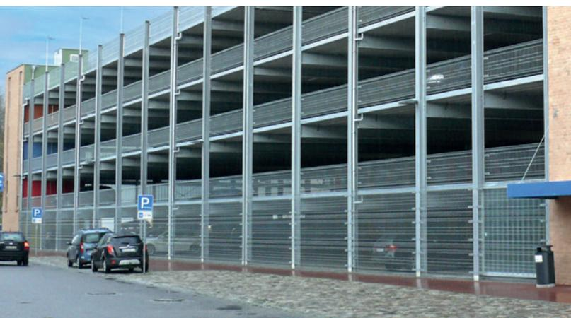
INTEGRA-pw Verschließung Erdgeschoss
